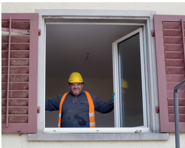
Wie erleben Sie die Vogelsang-Baustelle? Teilen Sie Ihre Eindrücke mit uns. Foto: PB
