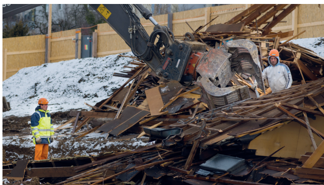
Bei der Entkernung werden die einzelnen Baumaterialien erst getrennt und dann abtransportiert. Foto: PB
