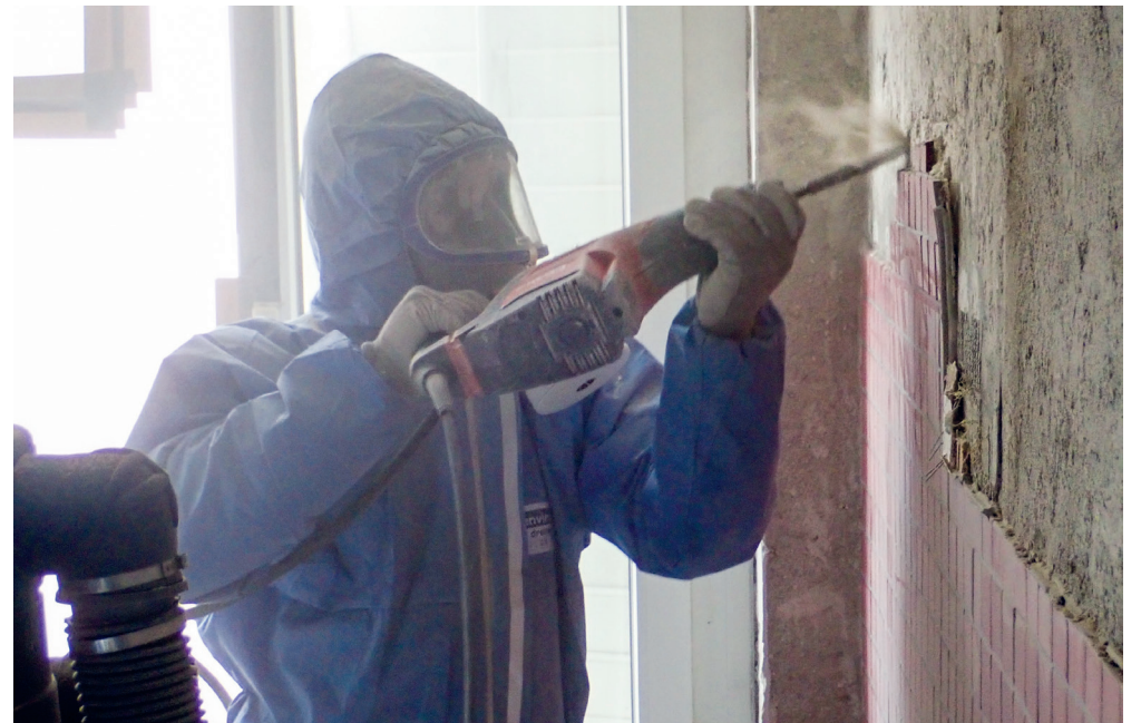
Mühevoll muss mit der Bohrmaschine jede einzelne Fliese von der Wand beseitigt werden. Der Schutzanzug, die Schutzmaske und strenge Sicherheitsvorkehrungen verhindern, dass auch nur das kleinste Körnchen asbesthaltiger Staub in die Lunge kommt. Fotos: PB
