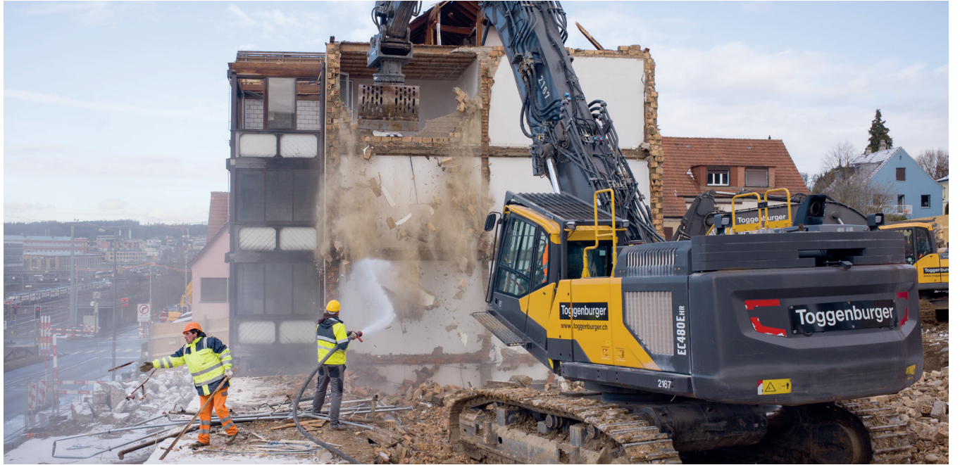
Rund 80 Jahre hat dieses Haus an der Unteren Vogelsangstrasse gestanden. Der Abbruch dauerte nur wenige Stunden. Foto: PB
