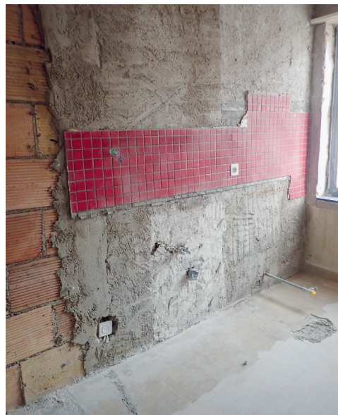
So sieht es nach der Asbestentfernung aus.
