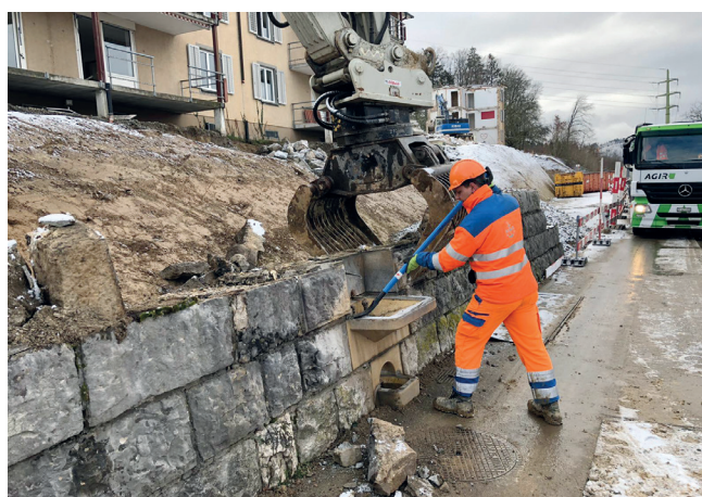
Bevor der Brunnen aus der Mauer herausgebrochen werden konnte, musste erst einmal das Wasser abgestellt werden. Foto: DF
