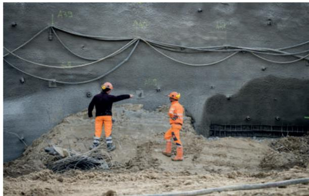
Die steilen Baugrubenböschungen werden mit sogenannten «Nagelwänden» gesichert. Foto: MR
