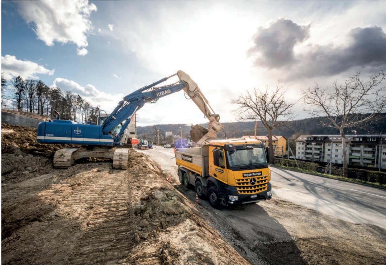
Fast wie am Fließband kommen die Lastwagen angefahren. Insgesamt transportieren sie 80 000 Kubikmeter Aushubmaterial weg vom Vogelsang. Das sind pro Tag 120 volle Lastwagenmulden. Foto: MR
