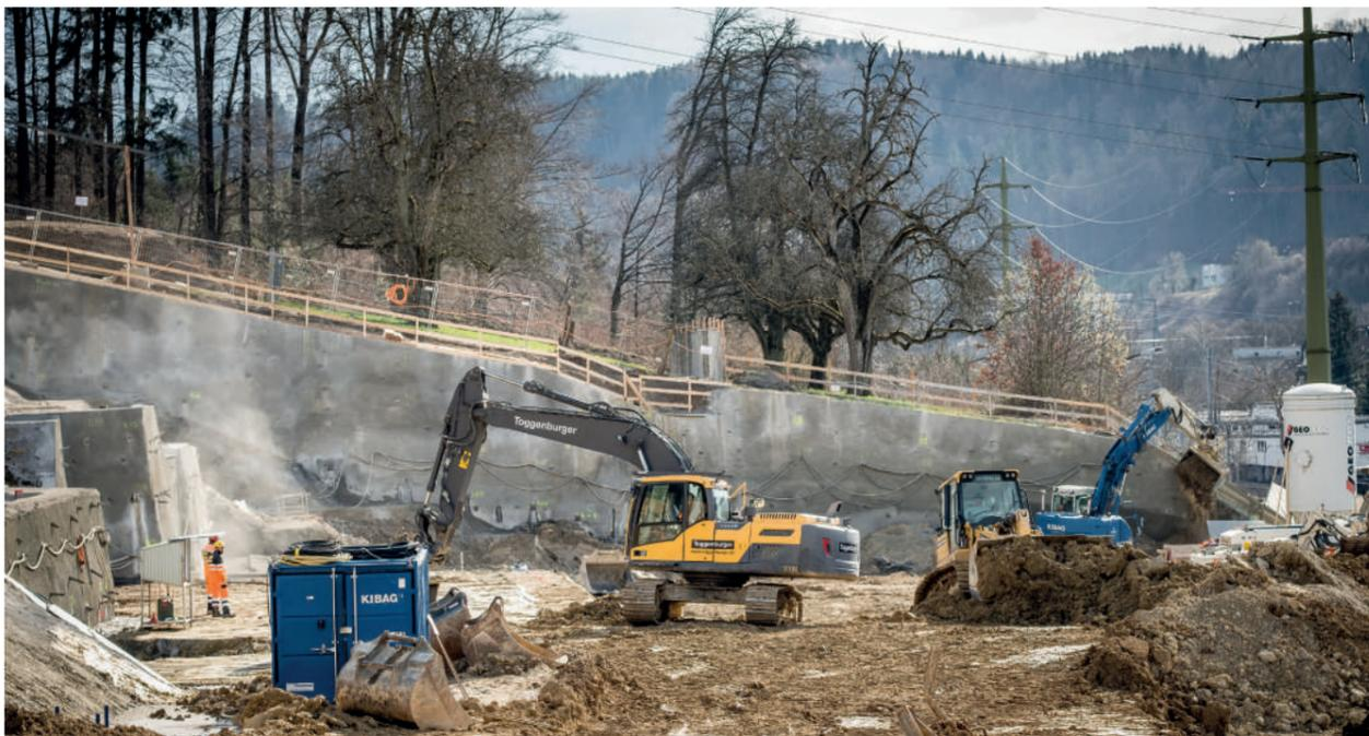
Wo heute noch Bagger die Baugrube ausheben, stehen später einmal die 18 Velohallen und die Tiefgarage. Die steile Böschung ist bereits abgesichert. Fotos: MR
