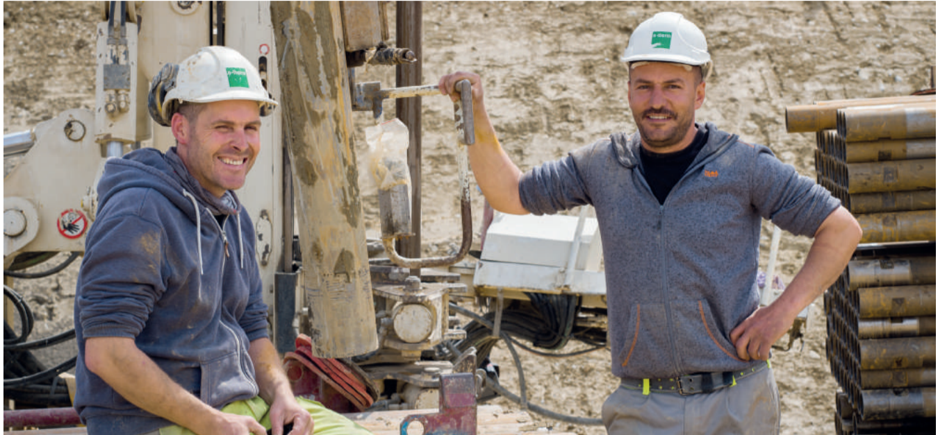
Bohren nach Wärme aus der Tiefe: Dieses Bohrteam der Firma e-therm sorgt dafür, dass es dank Erdsondenheizung im neuen Vogelsang zu jeder Jahreszeit in der Wohnung gemütlich ist. Fotos: PB
