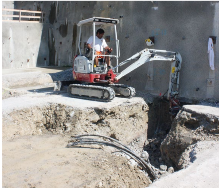
Obacht, Graben! Dieser Bagger musste vorsichtig zwischen den bestehenden Gräben fahren, bevor mit dem Wegbohren von Felsbrocken begonnen werden konnte. Fotos: LZ
