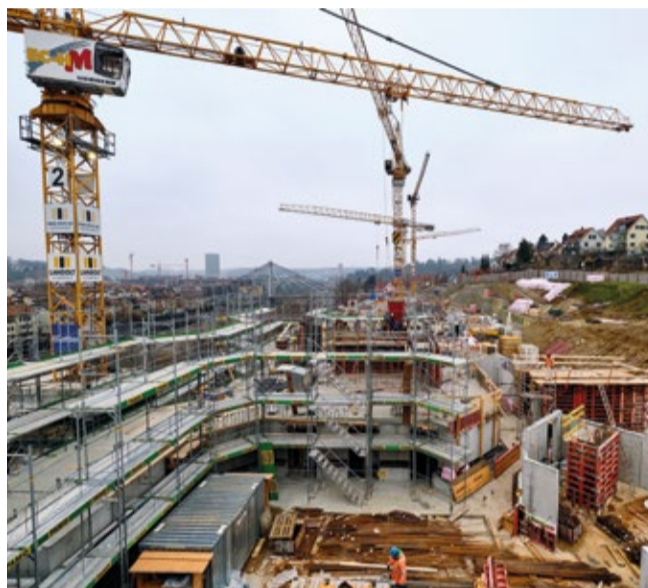
Die Gerüste werden für das Erstellen der Aussenwände und Decken benutzt und müssen daher sehr früh erstellt werden. Fotos: MR
