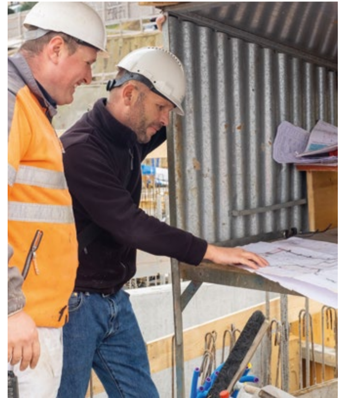
Doppelte Kontrolle ist am besten. Christian Allenbach überprüft mit Valon Sulejmani, dem Polier der Landolt AG, ob alles nach Plan gebaut wurde und bespricht offene Fragen. Foto: IP
