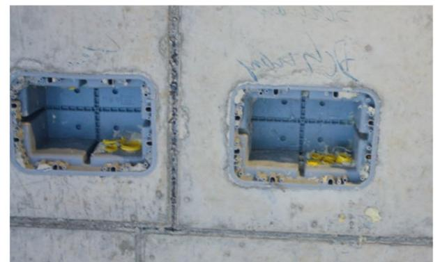
Dosen für die Deckenbeleuchtung werden auf der Deckenschalung montiert und anschliessend von Beton umgossen. Bild: LZ
