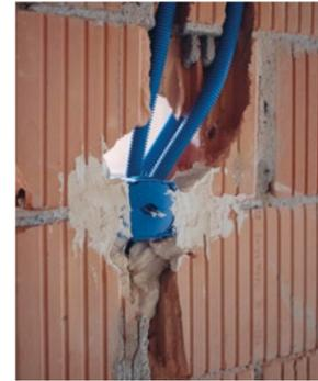
Die Backsteinmauer wird «aufgespitzt», damit darin die Rohre montiert werden können, in welche später die Kabel eingezogen werden. Bild: MA
