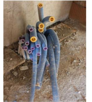
In der Steigzone jeder Wohnung legen die Elektrikerinnen und Elektriker die Rohrschlüsse für den Sicherheitskasten und das Telefonfestnetz. Bild: LZ
