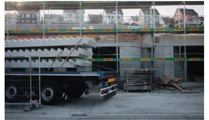
Pro Transport können bis zu zehn Standardtreppen transportiert werden.
