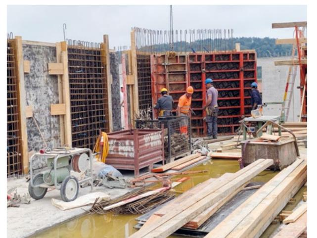
Die Schalungselemente können aus Kunststoff, Holz oder Beton sein. Das Material beeinflusst die spätere Betonoberfläche. Foto: GV
