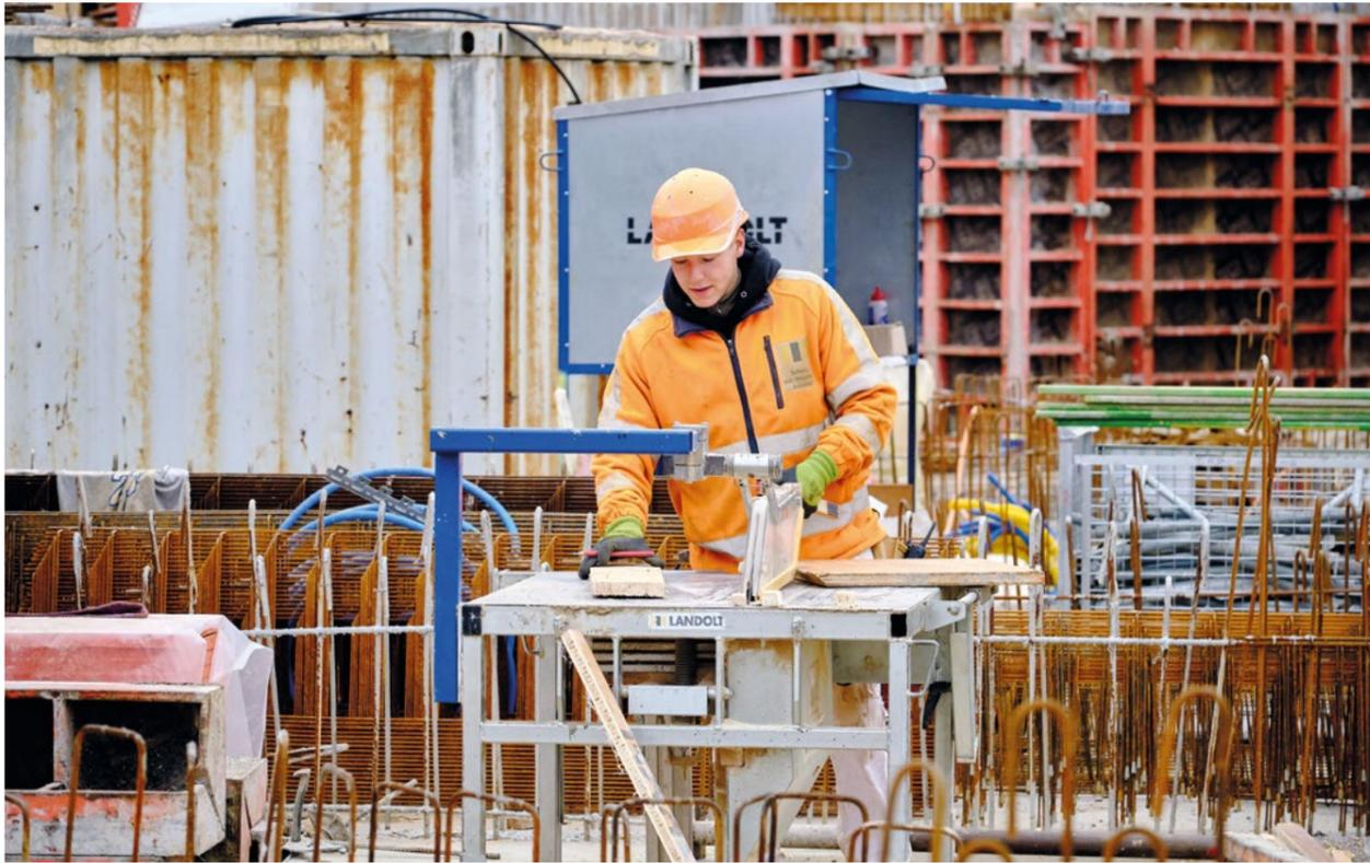
Die Schalungen und Bewehrungen müssen bereit sein, bevor der Kran neuen Beton bringt. Dafür werden auch Schalungsbretter punktgenau zurechtgesägt. Als Maurer, der im Betonbau arbeitet, muss Beni Gasser weit mehr können als nur den Beton giessen. Foto: MR
