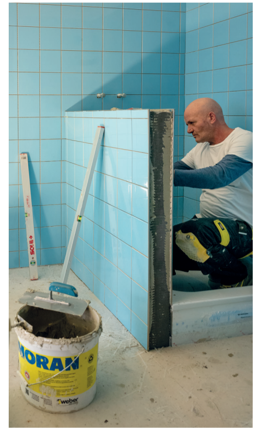
Wenn der Fliesenkleber getrocknet ist, wird die geflieste Fläche noch mit Fugenmörtel verbunden.
