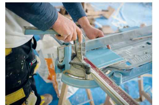
Die Wandplatten sind aus Steingut. Bei der Herstellung verschmelzen die Kristalle nicht. Das erleichtert das Schneiden.
