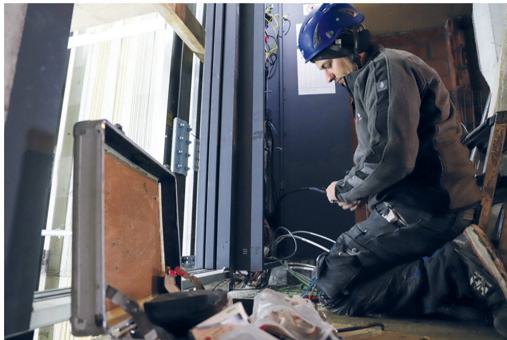
Bevor die Edelstahlkabine eingebaut werden kann, müssen die Schienen an der Seite montiert sein. Bilder: NE
