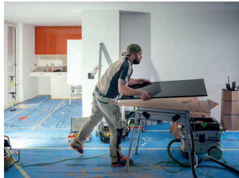
Zwei Wochen braucht ein Team von vier Monteuren für den Einbau von etwa 14 Küchen – 21 verschiedene Küchentypen gibt es insgesamt. Bilder: PB
