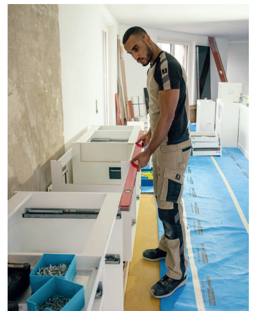
Wichtiges Utensil beim Stellen der Unter- und Oberbauten: die Wasserwaage.
