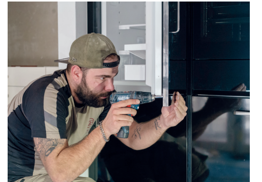
Erst zum Schluss werden die Küchenfronten passgenau montiert.
