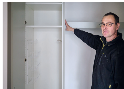
Der Monteur, Roger Mühle, montierte einen weiteren der knapp 170 Einbauschränke.
