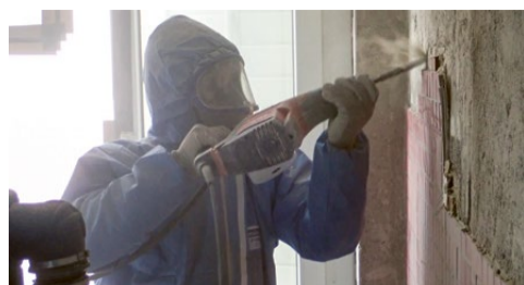
Februar 2019: Vor dem Abbruch musste mühevoll der Asbest in den Küchen entfernt werden, erst danach konnten die Abrissbagger ans Werk. Bild: PB
