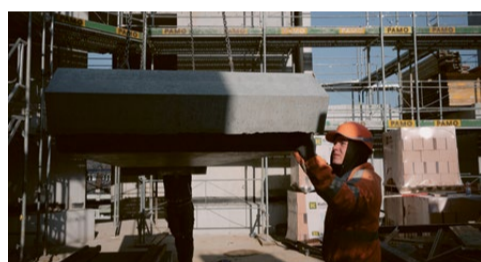
Mai 2020: Mitten in der Corona-Krise ging es im Vogelsang stets «bergauf»: Im Rohbau wurden dafür rund 100 Treppenelemente aus Stahlbeton mit je einem Gewicht von rund 3 Tonnen verbaut. Bild: MA
