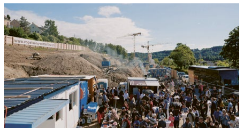
Juni 2019: Über 200 Menschen kamen zur Grundsteinlegung auf die Baustelle. Zum Schluss wurde die Zeitkapsel verschlossen. Bild: MA
