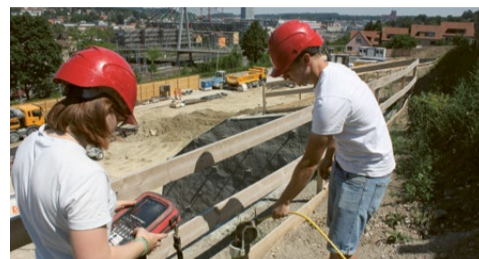
August 2019: Mit dem Inclinometer wurde sichergestellt, dass sich die Baugrube nicht verschiebt. Erst nach dem Hinterfüllen galt sie als stabil. Bild: LZ
