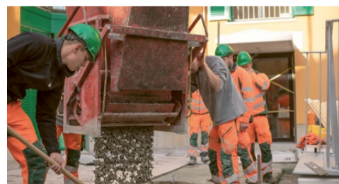
Oktober 2021: Der Splittbeton dient als Unterlage für den Gussasphalt – welcher in manchen Höfen aufgrund der Wetterlage erst im Frühling 2022 aufgetragen werden konnte. Bild: NE
