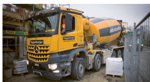
November 2019: Insgesamt wurden im Vogelsang 22 000 Kubikmeter Beton verbaut – produziert wurde er im Betonwerk Hard. Bild: PB
