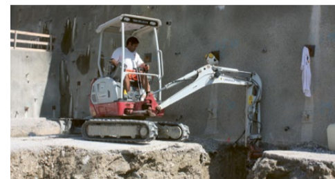
September 2019: In den Gräben unter dem Fundament wurden die Abwasserrohre im Boden verlegt. Bild: LZ
