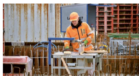
Dezember 2019: Die Schalungen und Bewehrungen mussten rechtzeitig für die Betonladungen bereit sein. Manche Teile wurden dafür zurechtgesägt. Bild: MR
