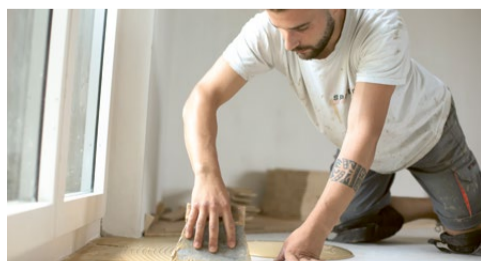
Juli 2021: Bevor der Parkettboden «Eiche natur, versiegelt» verlegt werden konnte, musste der Eco-Leim lückenlos auf dem Boden verteilt werden. Bild: MR
