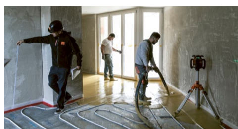
Oktober 2020: Während im Norden noch der Rohbau im Gang war, startete im Süden der Innenausbau. Unter anderem wurde in 94 Wohnungen eine vanillegelbe Anhydritmasse als Bodenbelag verteilt. Bild: MF
