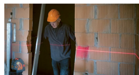
November 2020: Damit keine Feuchtigkeit in die Wohnungen eindringen konnte, wurden die Türen und Fenster eingebaut. Das Einpassen der 1200 Türzargen ging dank Wasserwaage und langer Erfahrung der Handwerker ruckzuck. Bild: PB
