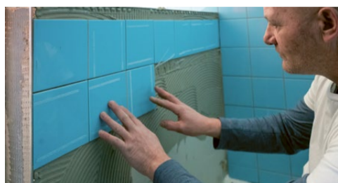
Januar 2021: Auf rund 6000 m 2 Fläche wurden die himmelblauen und bachgrünen Plättli aus robustem Steingut an den Badezimmerwänden platziert. Bild: PB
