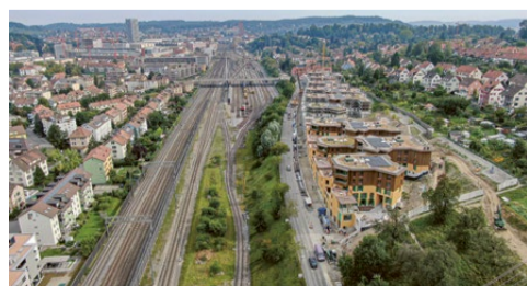
September 2021: An sonnigen Tagen produziert die Solaranlage bis zu 600 Kilowattstunden Strom für die Haustechnikanlagen. Bild: MR
