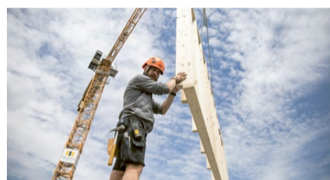
Juni 2020: Das Fichtenholz für die Unterseite der Dächer und Teile der Fassade stammt aus der Region. Die Holzelemente wurden vorgefertigt auf die Baustelle geliefert. Bild: MF
