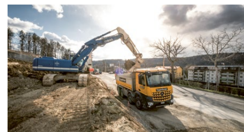
April 2019: Pro Tag transportierten 120 Lastwagen rund 1500 Tonnen Material zur Inertstoff-Deponie. Bild: MR
