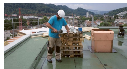
August 2020: Die Kupferelemente wurden passgenau zugeschnitten an das Vordach montiert. Danach kamen Solarmodule und wasserspeichernde Pflanzen auf die 5400 m 2 grosse Flachdachfläche. Bild: PB
