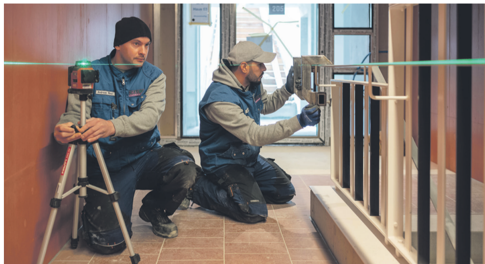
Mit dem Laser ausgemessen, gerät sicher nichts in Schiefelage. Bilder: PB
