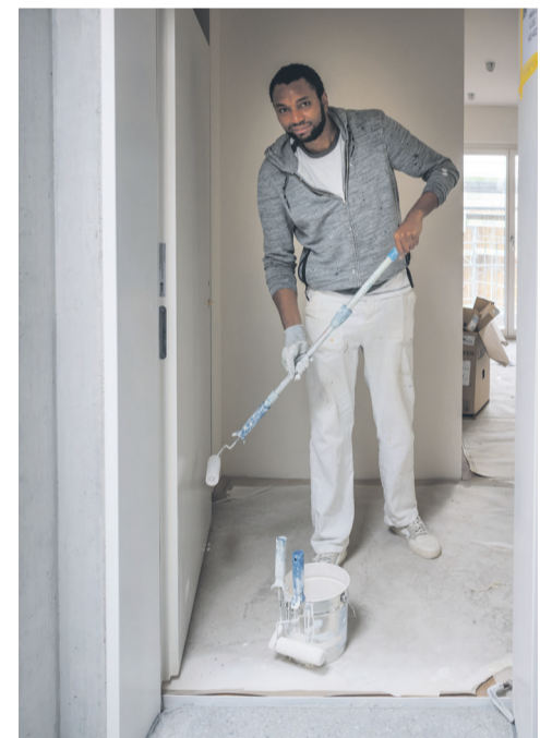
Gut geschützt ist halb gestrichen: Einen grossen Teil der Arbeit nimmt das Abdecken in Anspruch.
