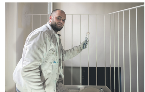
Mit dem Farbbroller kommt man beim Treppengeländer in den Maisonette-Wohnungen gut an alle Seiten heran.
