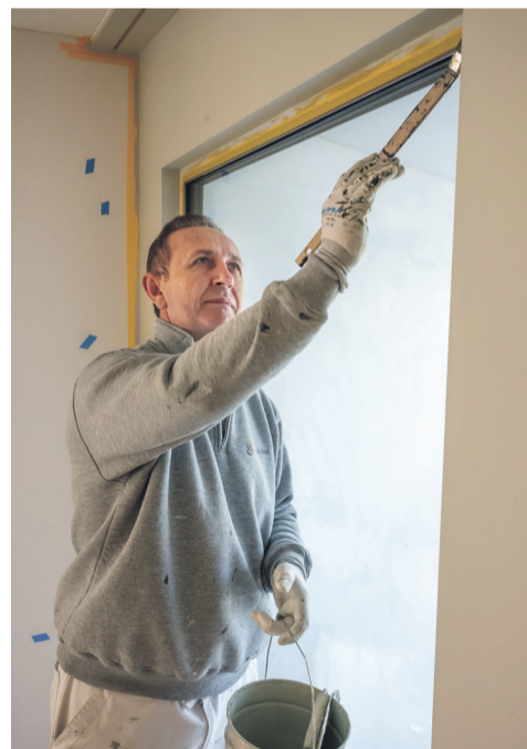
Details wie die Innenecken der Türrahmen müssen sorgfältig mit kleineren Pinseln ausgeführt werden.
