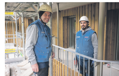
Holzplatten aus Fichte sorgen an der Balkonbrüstung für Abwechslung.
