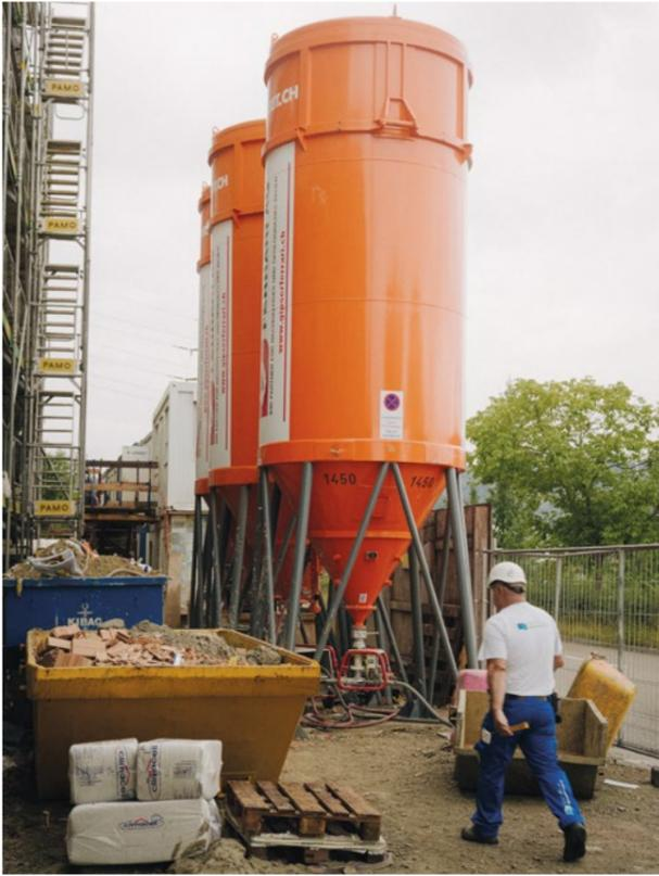
Die Materialsilos ermöglichen eine speditive Arbeitsweise. Bilder: MA
