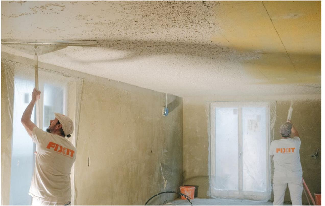
Um den Deckenverputz zu erstellen, muss mühsam «über Kopf» gearbeitet werden.
