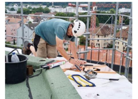
Die Blechbahnen aus Kupfer werden fachmännisch zusammengefügt und während der Bauzeit mit einem Schutzvlies abgedeckt. Bilder: PB
