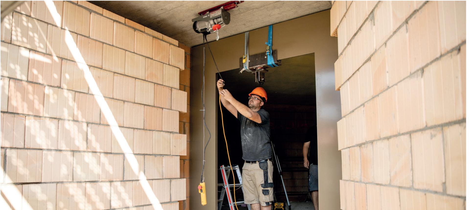
Die Montage der schweren Brandschutzfenster wird durch die Hebehilfskonstruktion an der Betondecke erleichtert. Bilder: MF
