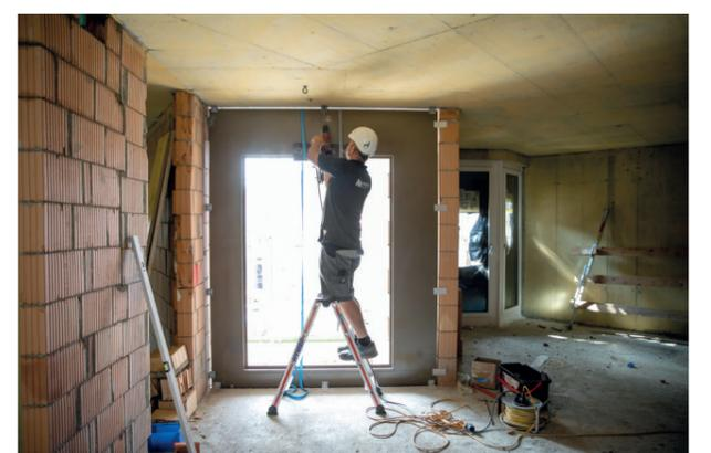
Auf der Innenseite werden die Fensterrahmen an die Betonbauteile montiert.
