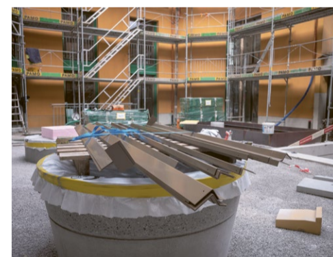
Das Material liegt im Innenhof bereit für die Montage.
