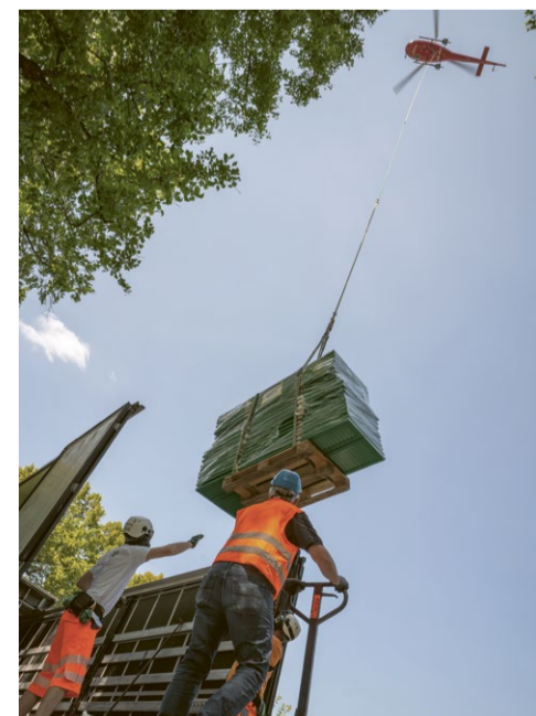
Die Firma Jaloumatic liess die schweren Alu-Klapp-läden für die Montage mit dem Helikopter auf die Baustelle liefern – das war logistisch die schnellste und einfachste Lösung.
