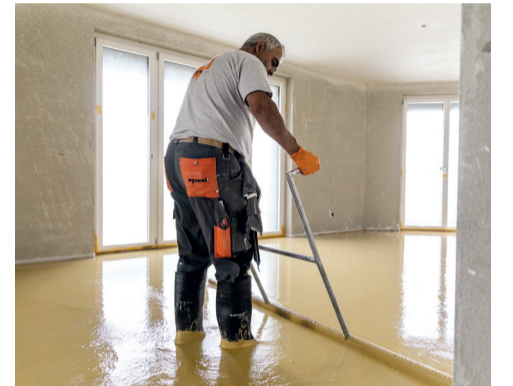
Für eine gleichmässige Oberfläche wird die Masse mit der «Schwabbelstange» noch «geschwabbelt».
