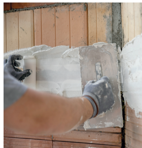
Die Gewebeeinbettung verleiht dem Putz eine höhere Zugfestigkeit und schützt vor Rissen.
