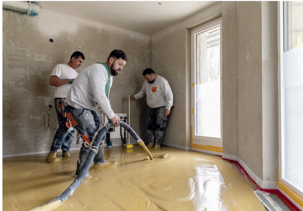
Beim Giessen der Anhydritmasse muss es schnell gehen: Die Masse ist nur für etwa 45 Minuten gut verteilbar. Bilder: MF
