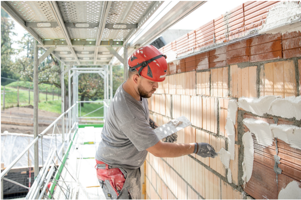
Der Leichtputz wird direkt auf das Mauerwerk aufgetragen. Bilder: MF
