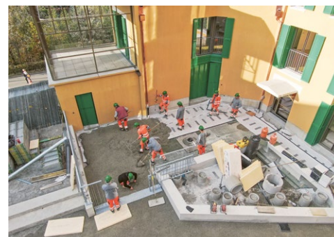
Bildlegende: Der Splittbeton muss gleichmässig verteilt werden, da er als Unterlage für den Gussasphalt dient.
