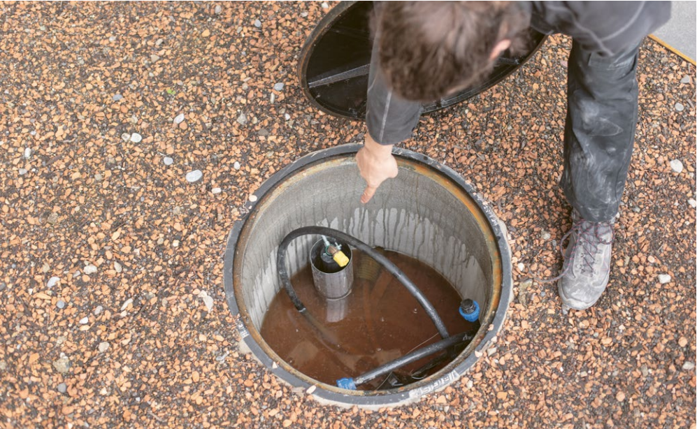
Es fehlt nur noch der Anschluss, dann können die Pflanzentröge bewässert werden.
