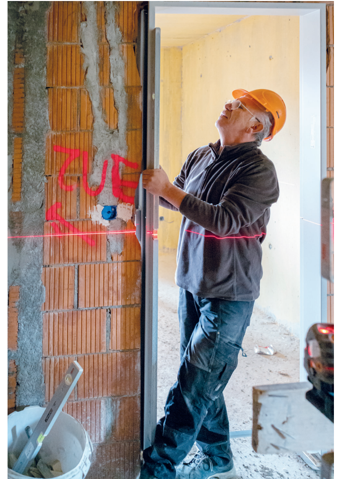
Eine Wasserwaage hilft beim präzisen Ausrichten der Türen. Zum Schluss wird der Hohlraum zwischen dem Mauerwerk und der Stahlzarge mit Mörtel ausgegossen, wodurch die Zarge fest mit dem Gebäude verbunden wird.
