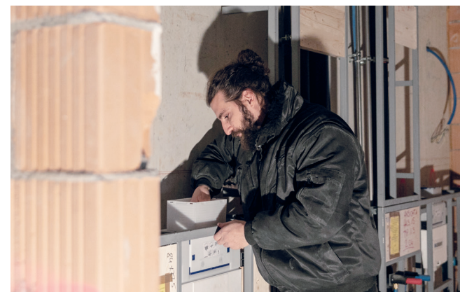
Die Kontrolle der Sanitärinstallationen ist genauso wichtig wie die Installation selbst.
