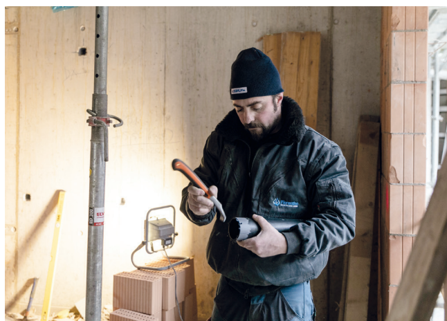
Elektroschweissmuffen – also Rohrverbindungen – machen die Übergänge der einzelnen Rohre dicht. Dafür müssen sie vorab bearbeitet werden. Bilder: MF
