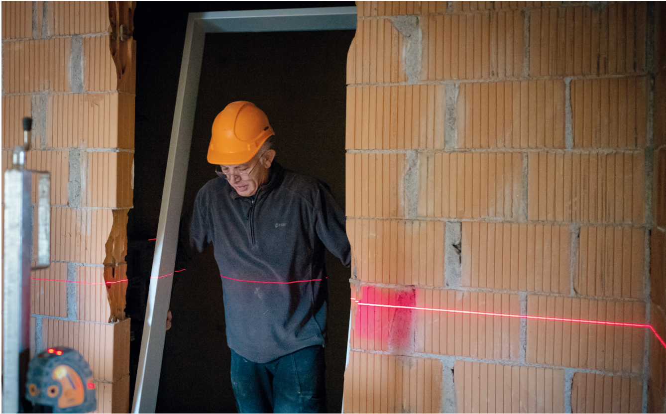
Ruckzuck hat Stahlzargenmonteur Cosimo La Torre die Türzarge aufgerichtet und in die Türöffnung eingepasst. Bilder: PB
