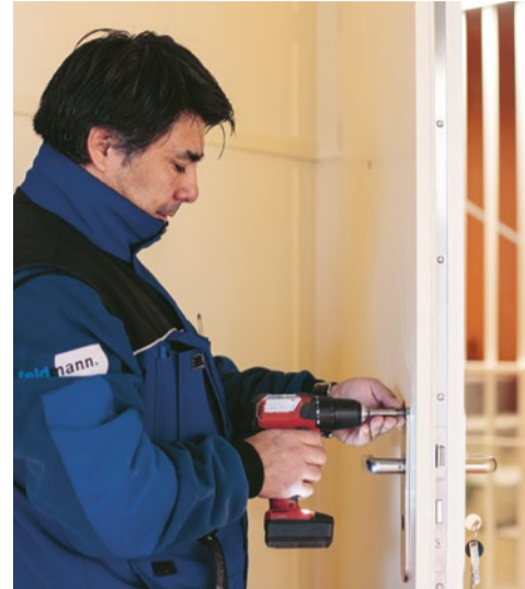
Türschilder werden für die Zylindermontage demontiert und anschliessend wieder montiert.
