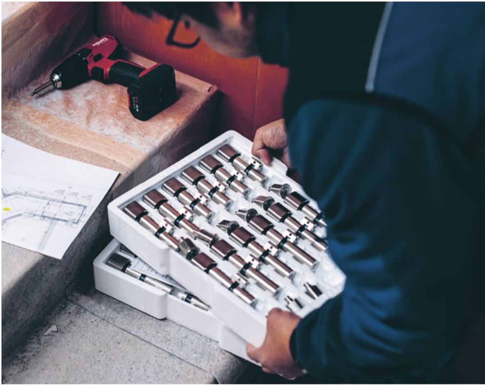
Welcher Schliesszylinder gehört wohin? Dies kann Alberto Manquilef, Monteur bei der E. Feldmann AG, aus dem vorbereiteten Plan herauslesen. Bilder: NE
