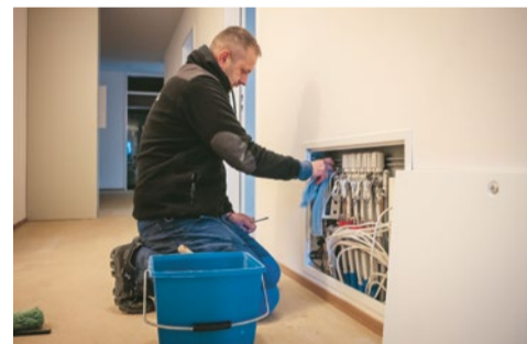
Mit grosser Vorsicht: die Reinigung des Heizverteilers.
