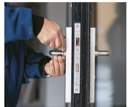
Die Montage eines Elektronik-Langschildes (C-Lever) kann nur durch geschultes Personal erfolgen. Da die Elektronik auf der Innenseite ist, müssen noch Verbindungskabel durch das Türblatt geführt werden. Programmierung und Funktionskontrolle erfolgen anschliessend.
